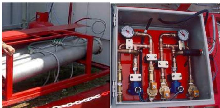
Figura 86: Balas de hidruros Lab-Tech y cuadro del control del hidruro
