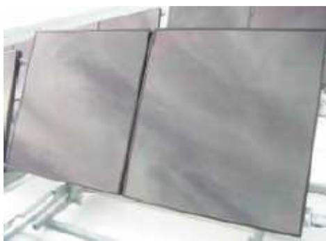
**Figura 78: Paneles silicio Amorfo**
