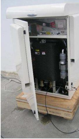
Para la conversión del Hidrogeno generado en energía eléctrica, se ha elegido un pila de la marca “PlugPower” modelo GENCORE 48B de una potencia de 5.0kW.
