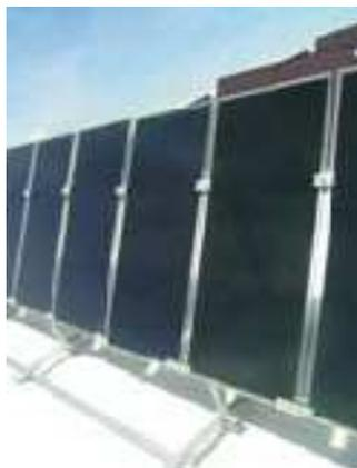
Figura 79: Paneles de CdTe
