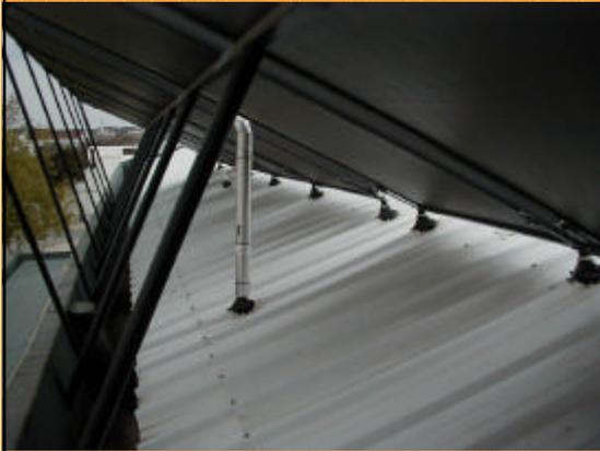
Acessório utilizado na travessia de chapas onduladas
