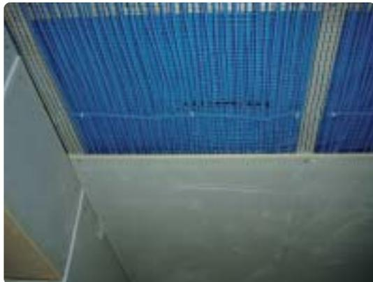
**Figura 2.-** Malhas capilares sobre guias e sob lã rocha em tecto falso de gesso.
