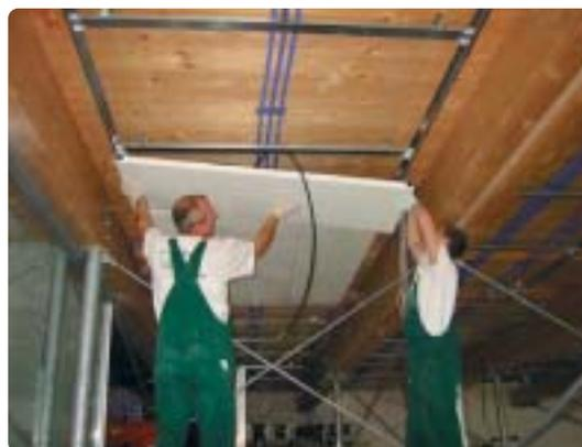
**Figura 4.-** Montagem dos módulos do tecto falso.
