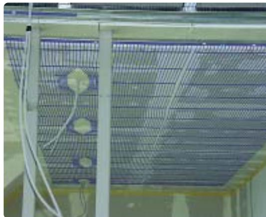
**Figura 4.-** Cavidades para a saída de cabos eléctricos.
