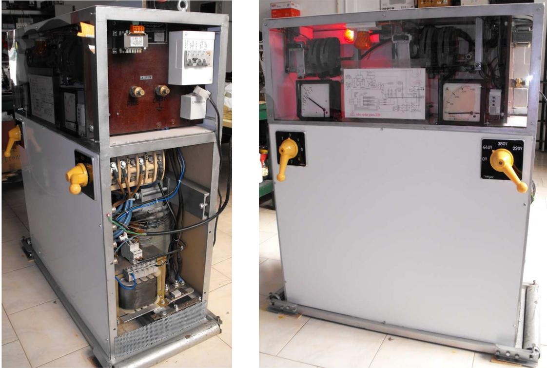
Imagem 8.21- Fonte de 400A para carros de choque, sem tampa lateral de alimentação
