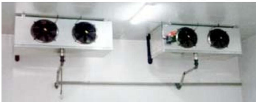
Figura 3.4 – Evaporador para resfriamento de ar (câmaras frigoríficas)
