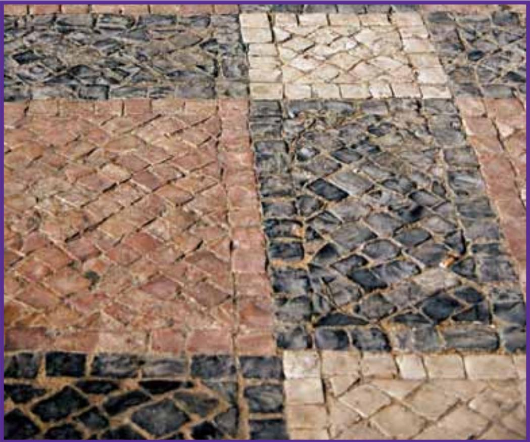
Figura 29 - Exemplos de trabalhos mal limpos: o cimento que ficou na superfície e secou vai levar bastante tempo a desaparecer. A calçada dificilmente ficará devidamente limpa se não for muito “passeada”.
