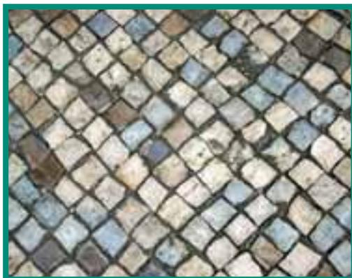
Figura 50 - Exemplos de calçadas com juntas de largura apropriada.
