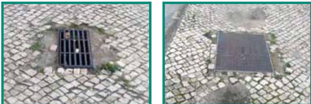
Figura 55 - Defeitos de calcetamento junto a tampas e caixas.
