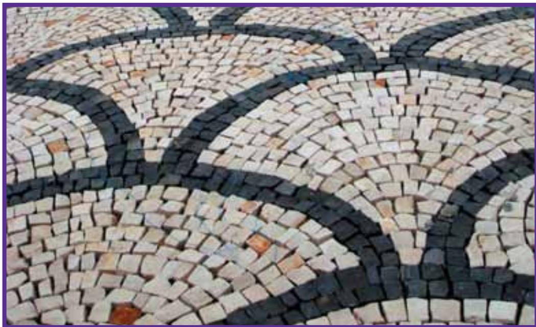
Figura 22 - Exemplo de trabalho com o espaço entre as calçadas (juntas) ainda por preencher.
