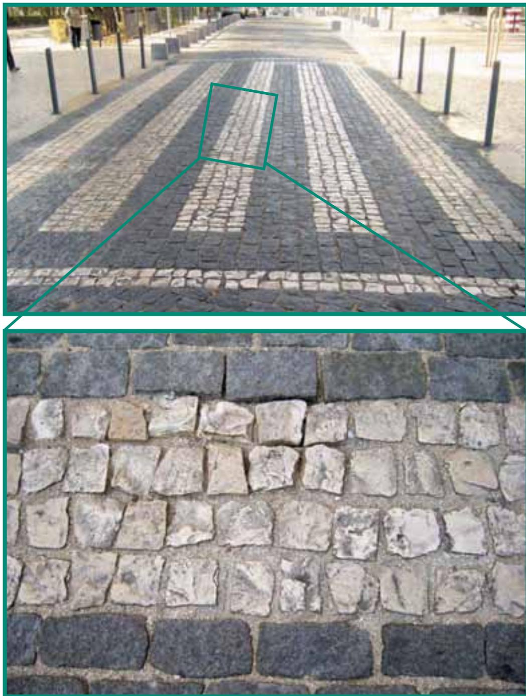
Figura 52 - Combinação de formatos pouco adequados para uma passadeira.
