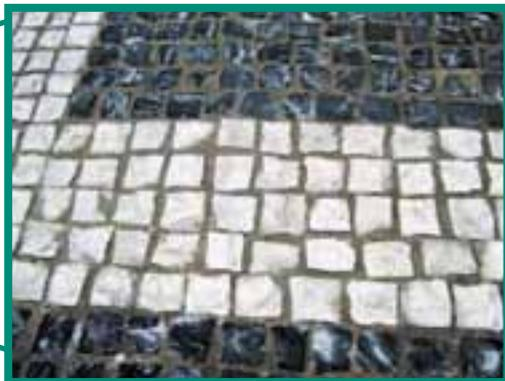
Figura 53 - Exemplo de uma passadeira bem confeccionada.
