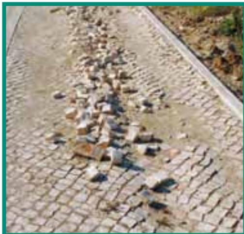
Figura 47 - Exemplos de má compactação da sub-base da calçada, com a consequente deterioração do pavimento por rodados de veículos.
