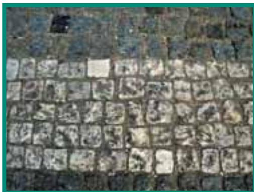
Figura 54 - Pavimento sujo de uma passadeira devido à utilização de calcários pouco duros.
