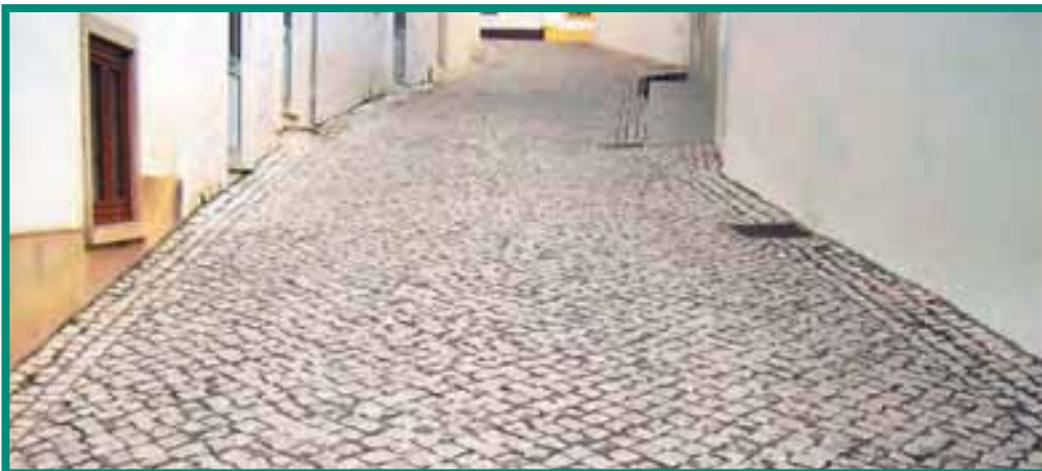
Figura 39 - Uma rua pavimentada com calçada branca.
