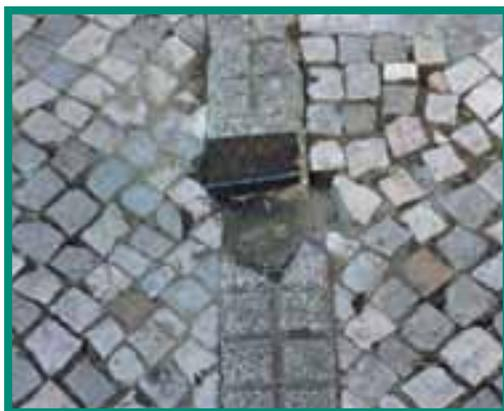
Figura 48 - Outros exemplos de deterioração do pavimento por má compactação da sub-base.
