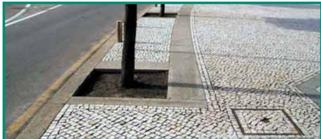
Figura 56 - Exemplos de bom calcetamento junto a caixas e tampas e em bordaduras.
