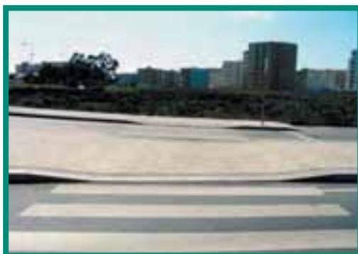
Figura 51 - Rampa para peões e um exemplo de calçada rebaixada.
