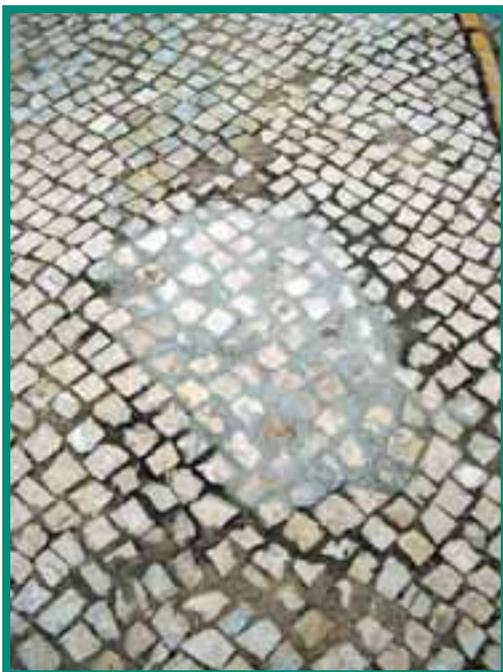
imagens da Figura 57, existem casos em que a pedra é assente sem obedecer ao padrão existente e sem qualidade na aplicação. Para se efectuar um bom trabalho de reposição é necessário recorrer a um calceteiro com experiência.
