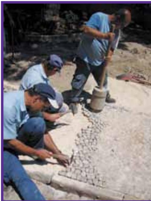
Figura 19 - Duas fases de um trabalho de calcetamento.
