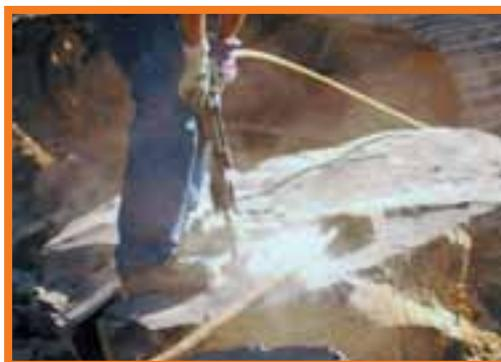
Figura 9 - Execução de furação com o martelo pneumático.
