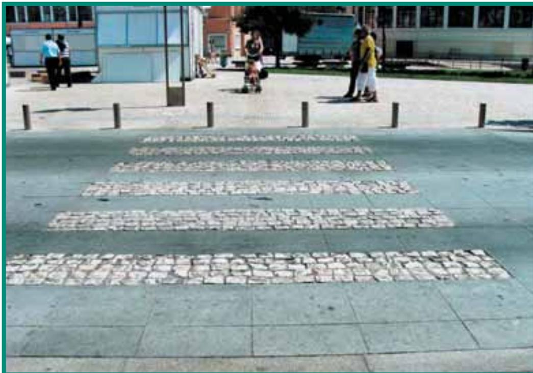
Figura 42 - Combinação de calçada branca com cubos (ver pg. anterior) ou lajes de granito.
