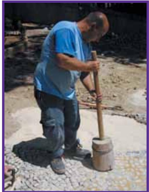
Figura 25 - Compactando a calçada com a placa vibratória e com o maço.
