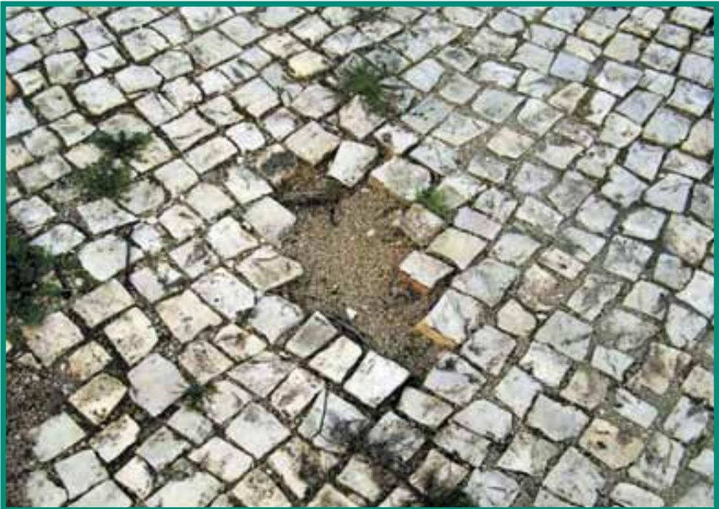
Figura 49 - Exemplos de calçadas com juntas de largura excessiva, mostrando a consequente deterioração do pavimento.
