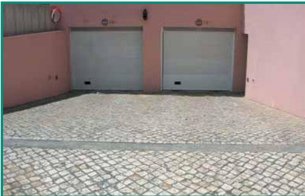
Figura 41 - Pormenor do pavimento de um parque de estacionamento confeccionado com calçada branca.
