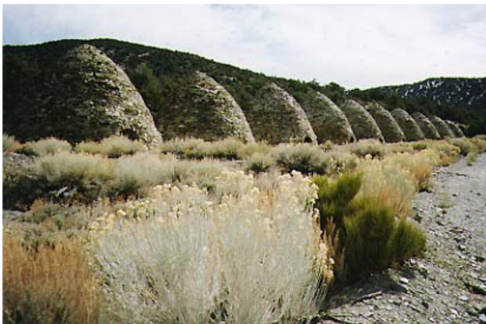
Figura 4 - Bateria de fornalhas de alvenaria (Fonte: US Forest Survey).
