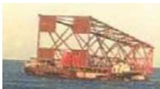
Fig.10 - Transporte de uma jacket, fonte: EL-Reedy pág. 367
