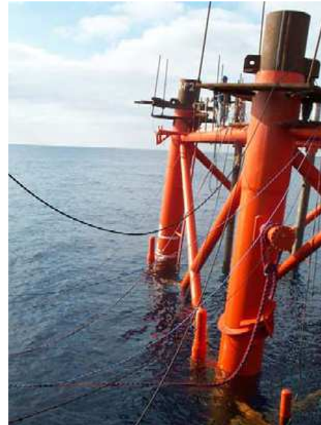
Fig.15 - jacket com estacas cravadas, EL-Reedy pág 379
