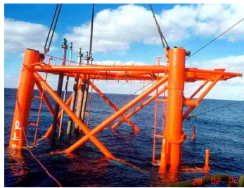
Fig.12 - colocação da jacket no local; fonte: EL-Reedy pág. 374
