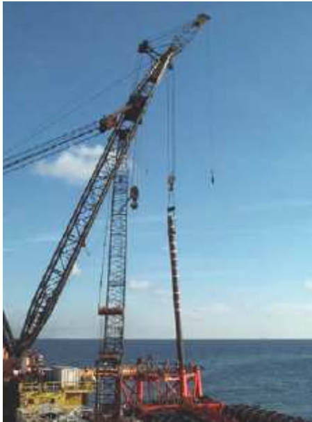
Fig.14 - Meter estacas, EL-Reedy pág 378
