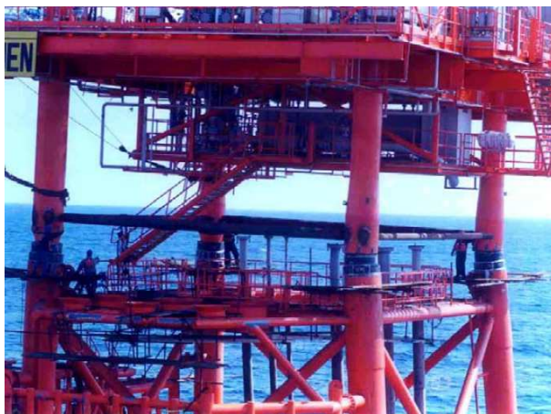
Fig.16 - Colocação do deck, EL-Reedy pág 373
