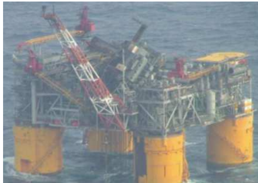
Fig.21 - Colapso estrutural devido ao furacão Katrina, Golfo México, fonte: OGP-2014.
