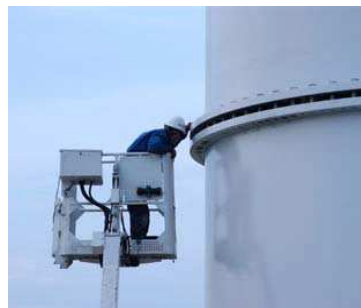
Fig.6 - Aperto de flange pelo exterior
