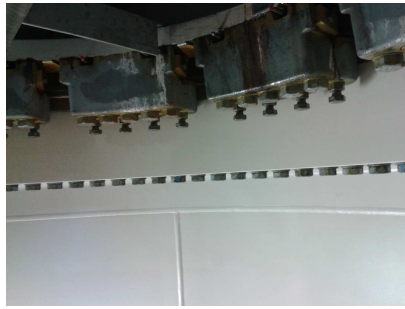
Fig.9 - Flange a fixar a nacelle
