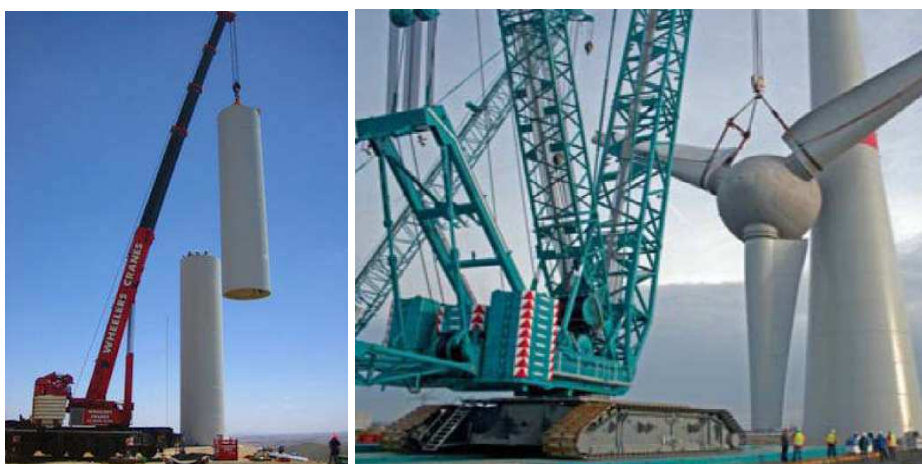
Fig.3 e 4– Gruas de grande capacidade necessárias na montagem
