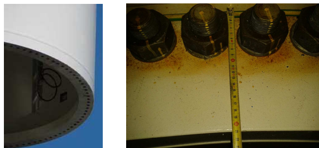
Fig.7 e 8 – flanges de aperto pelo interior
