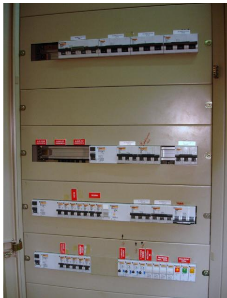
Figura 2.9 - Quadro de Emergência
