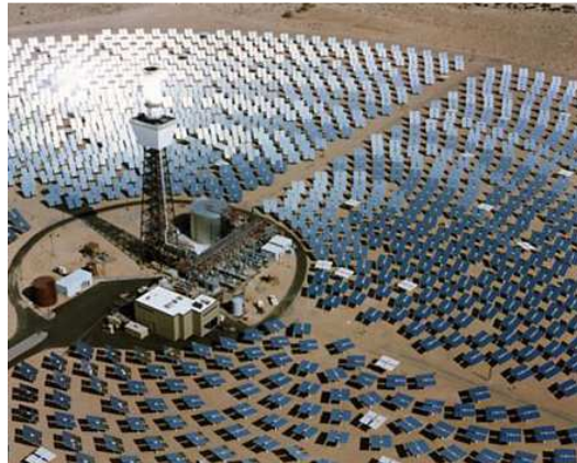
Figura 2352: Central de torre - Solar Two, deserto Mojave, Califórnia
