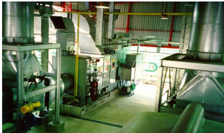
Fig.8 – Dois sistemas de Turbina a Gás (Fábrica de Cerveja Kaiser - Brasil)
