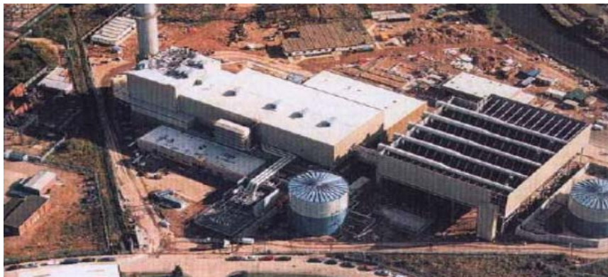
Fig.16 - Instalação industrial com sistema em Ciclo Combinado, uma Turbina a Gás e uma Turbina a Vapor, com sistema de condensação na zona à direita (Reino Unido)
