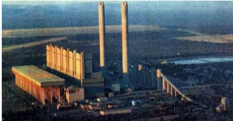
Fig.13 - Instalação industrial onde se usa turbinas a vapor, de notar à esquerda caldeira de condensação, uma das maiores do mundo (Matimba, Africa do Sul)
