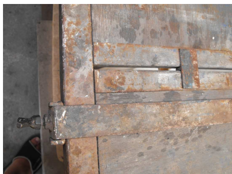
Imagem 2.5 - Pormenor do trilho com batente e braçadeira rectangular
