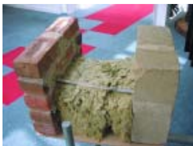
c) Pormenor do isolamento para exterior
