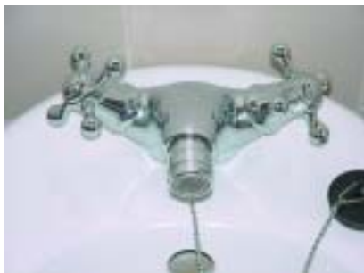
Figura 7-34 Pormenor dos redutores nas torneiras
