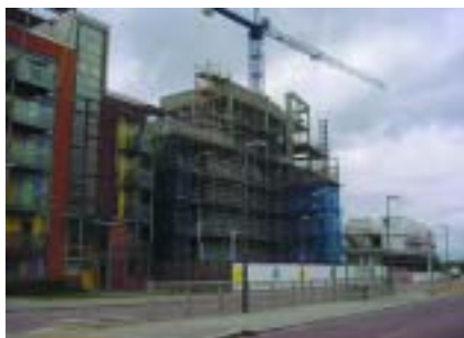
c) Zonas em construção
