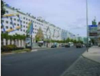
a) Via de acesso
