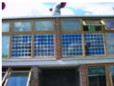
d) Pormenor do painel fotovoltaico
