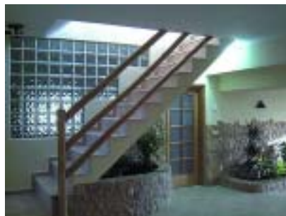
Figura 7-15 Tijolos em vidro entre a cozinha e a sala de refeições
