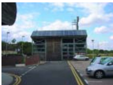
g) Zona de tratamento de efluentes e equipamento de apoio
