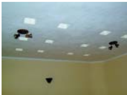
Figura 7-16 Pormenor dos tijolos em vidro entre pisos
