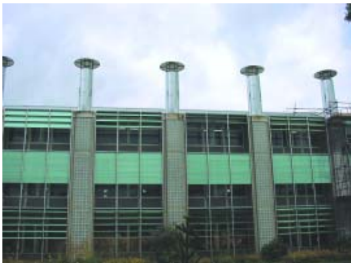
Figura 6-4 Pormenor da fachada com as suas chaminés marcantes e o sistema de controlo da iluminação
