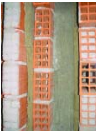
Figura 7-27 Pormenor construtivo da parede dupla e isolamento das caixas de estores
