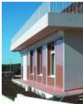
Figura 7-10 Paredes de armazenamento térmico no piso térreo
