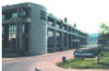
Figura 6-14 Pormenor da Entrada do Instituto do Ambiente
