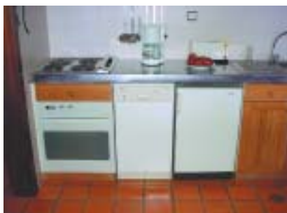
Figura 7-33 Pormenor dos equipamentos de cozinha no Hotel Jardim Atlântico
