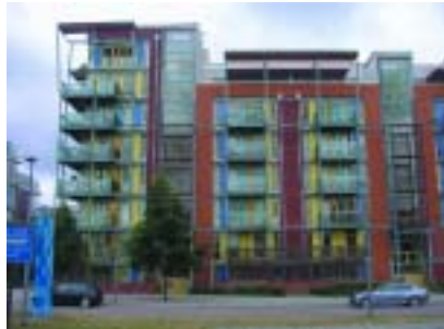
b) Pormenor de uma fachada de outra zona em desenvolvimento
