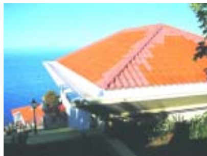
Figura 7-35 Beiral de recolha das águas pluviais no Hotel Jardim Atlântico
